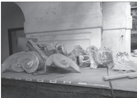
Repasované části dřevěných hlavic sloupů
