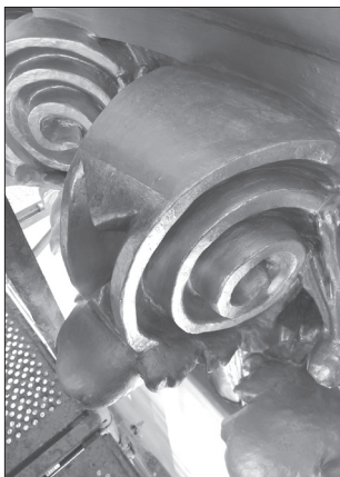
Repasované části dřevěných hlavic sloupů
