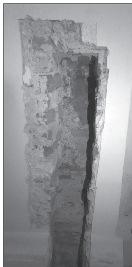
Odkrytí gotického sloupu v lodi
